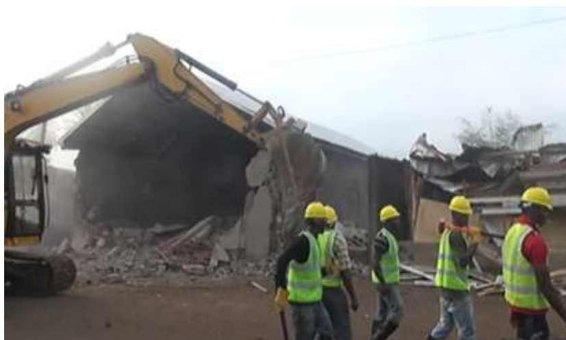
Photo 1. Démolition de l'Eglise Apostolique du Cameroun, Assemblée de NKOMBA, LIEU : NKOMBA, Source : Emission Grand Angle, LTMtv, DATE : Avril 2014
