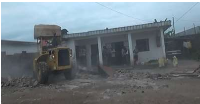
Photo 2. Démolition d'une maison d'habitation avec famille encore à l'intérieur
