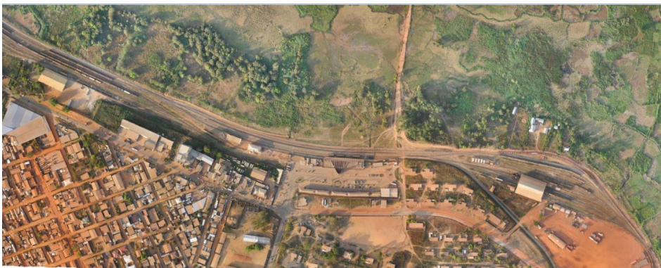
Photo/Picture 12. Vue partielle par drone du port sec de Ngaoundéré. Partial UAV view of the dry port of Ngaoundéré.
